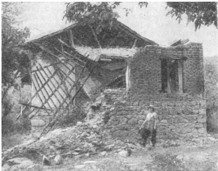
Здание в селении Мухас (Алазано-Агричайская долина), разрушенное землетрясением 1955 г.
